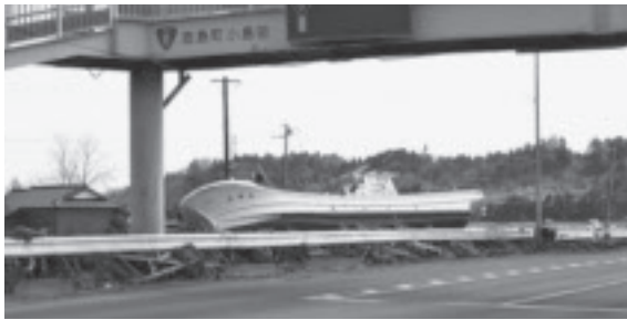
▲国道6号(南相馬市鹿島区)
